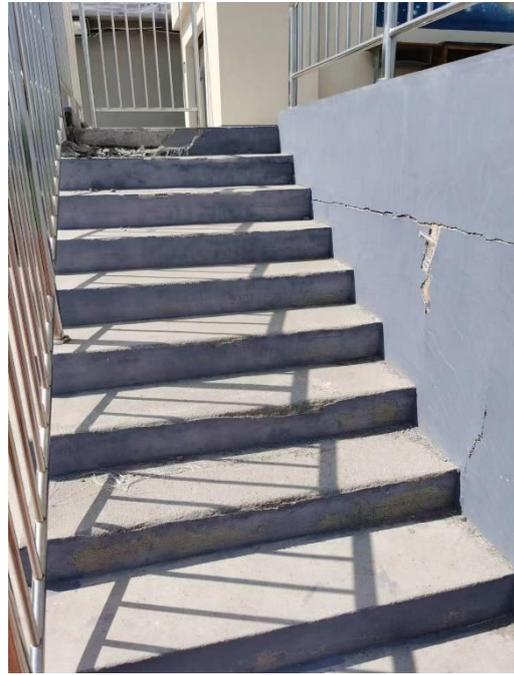
图 1-2 主席台楼梯台阶粉化、破损
