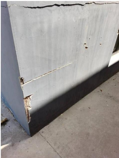
图 1-3 主席台外保层断裂、凹陷
